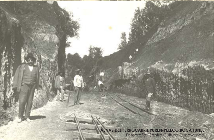
FAENAS DEL FERROCARRIL PURÉN-PELECO, BOCA TUNEL Fotografía: Centro Cultural Dungwunge
