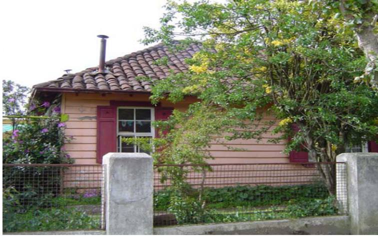
Muros de Madera – Cubierta de Teja Fotografía: Gonzalo Cerda Bintrup
