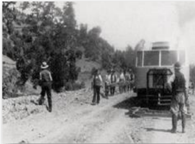
Fotografía N°12: Proceso de construcción Túnel Nahuelbuta
